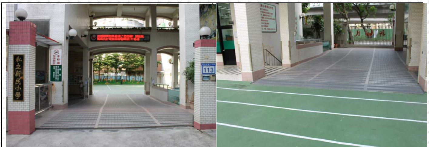
設置止滑緩坡道
